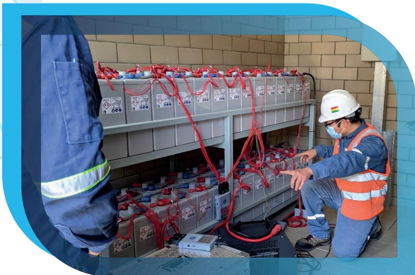
Mantenimiento preventivo y pruebas eléctricas a bancos de baterías de subestaciones: Planta Diésel, Laguna y Sucre T13.
