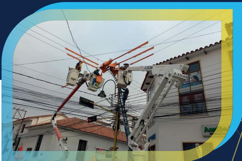
Trabajos de aislación de conductores, desarrollado para prevención de accidentes en edificación de construcción por contacto accidental.
