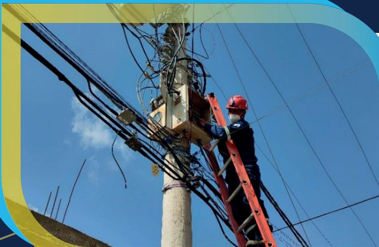
Seguimiento y mantenimiento preventivo en 73 centros de transformación, con la ejecución de: mantenimiento general de centros de transformación de distribución, limpieza, ajuste de conexiones de los dispositivos de seccionamiento-protección de media/baja tensión, pruebas de aislamiento, relación de transformación y pruebas de rigidez dieléctrica de aceite a transformadores de distribución, medición de resistencia de puesta a tierra y mejoramiento del sistema de aterramiento.
