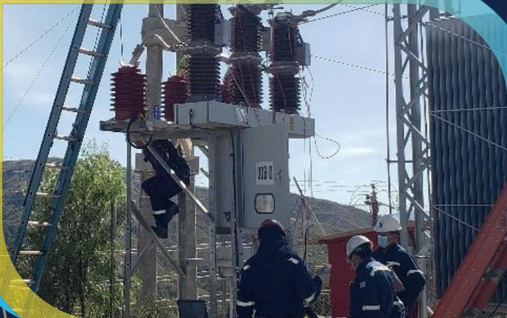
Mantenimiento preventivo en Subestación Sucre, con la ejecución de pruebas eléctricas a transformador de potencia T11, y equipos de patio asociados, transformadores de voltaje, transformadores de corriente, seccionadores, pararrayos e interruptores de potencia con personal y equipamiento propio.
