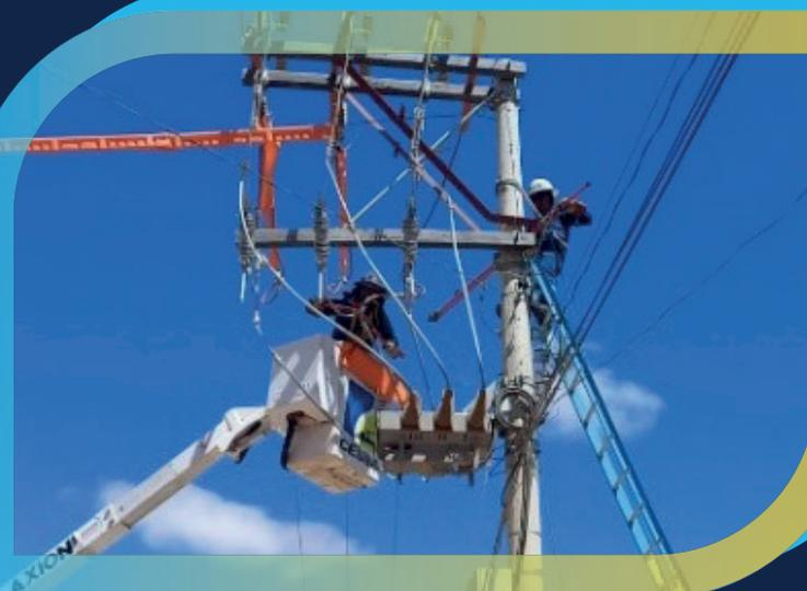
Instalación, montaje y puesta en marcha de 12 reconectores electrónicos en puntos estratégicos de la red de Media Tensión.
