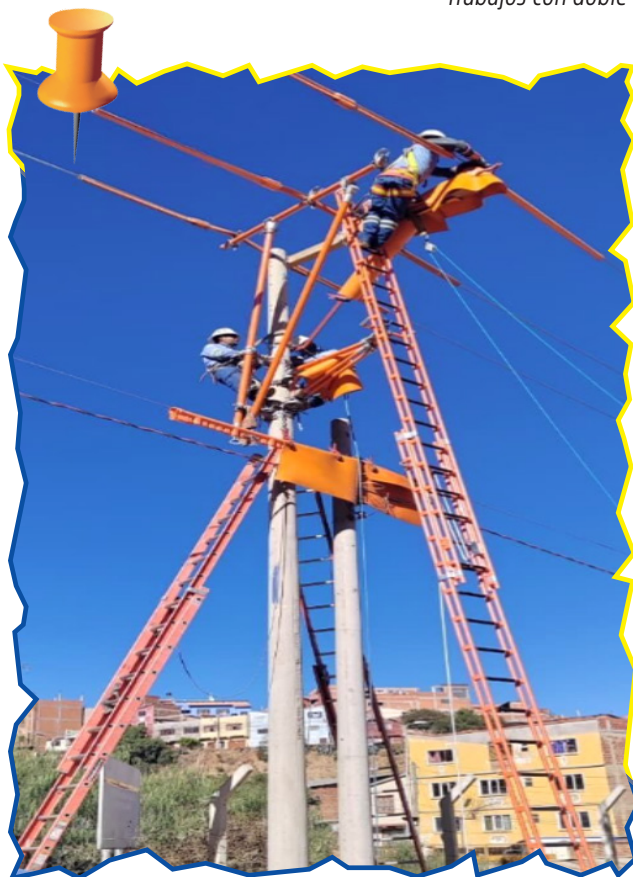
Trabajos con doble carro hidro-elevador
