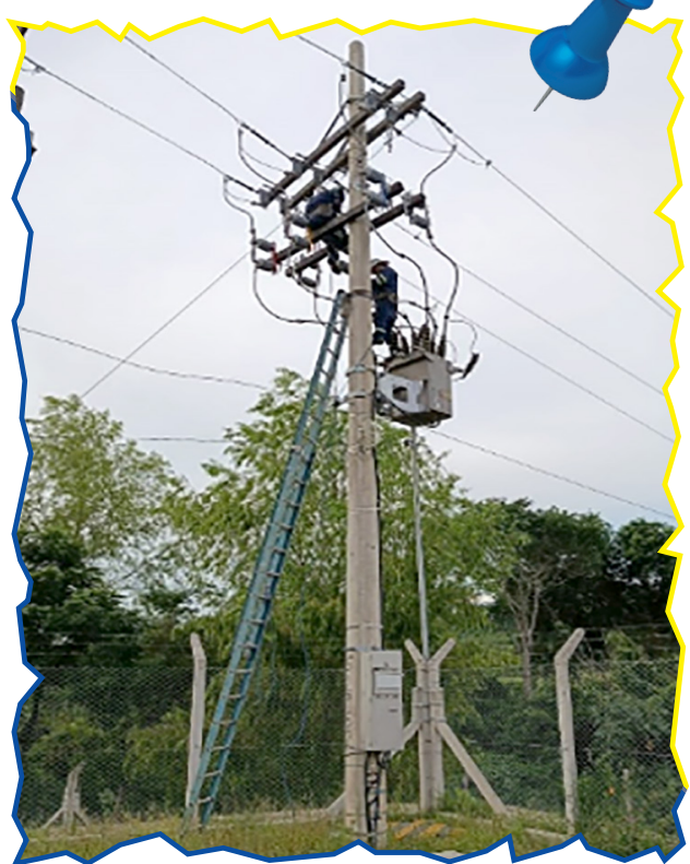
Termografía a equipos reconectores de la red de media tensión
