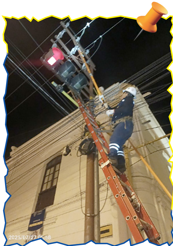
Trabajos de mantenimiento en caseta de la catedral.
