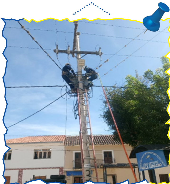
Mantenimiento transformador T1211, Villa Serrano
