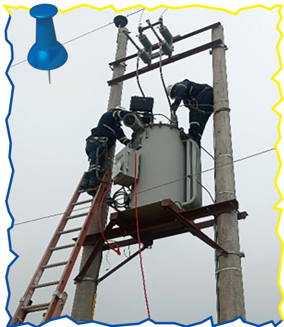
Pruebas eléctricas a regulador de tensión Villa Serrano
