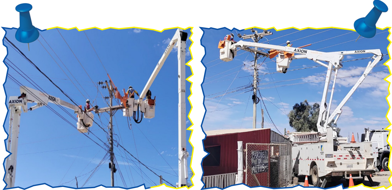
Trabajos con doble carro hidro-elevador
